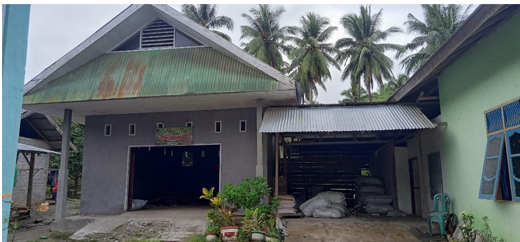
Kondisi Gudang Lumbung Pangan Kelompok Sumber Tani Rinda
