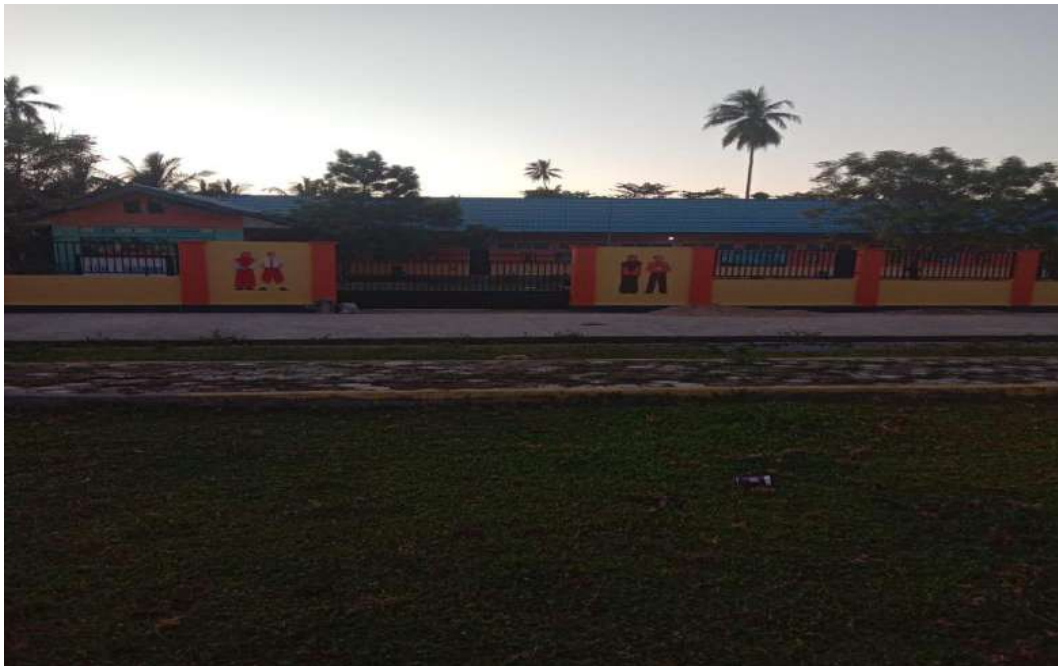
Gambar 2: Bangunan Sekolah dari Luar SDN 1 Salumbia
