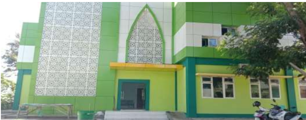
(Dokumentasi gedung asramah putra tampak depan MAN 2 Palu)
