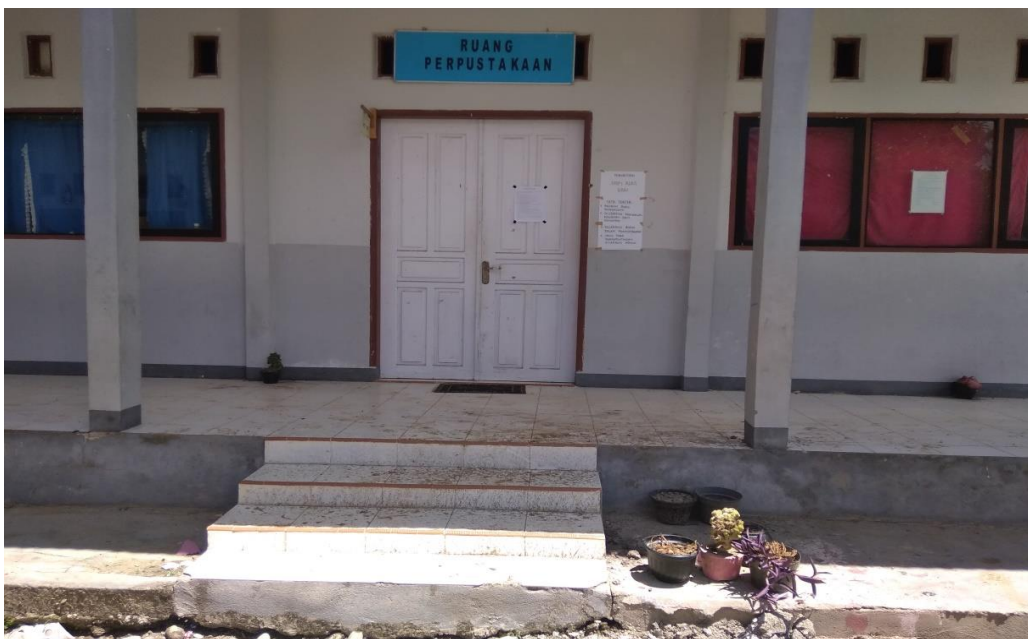
Gambar 4. Gedung Perpustakaan SMA Negeri 1 Bolano Lambunu
