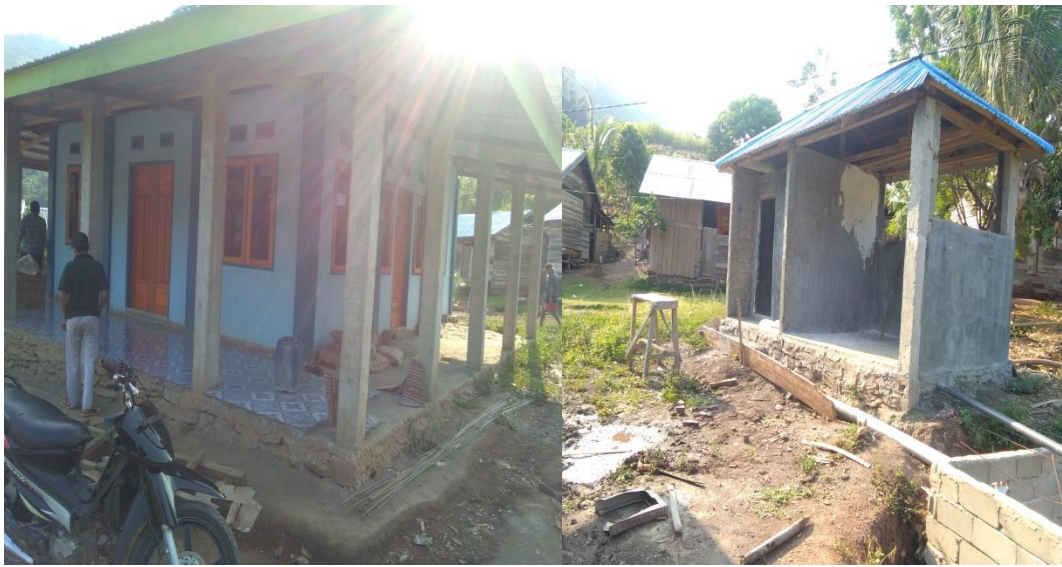
Gambar: proses pembangunan musollah pertama desa bambasiang
