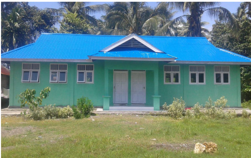
Foto gedung sekolah sore Madrasah Diniyah Awaliyah (MDA) di Desa Ambunu
