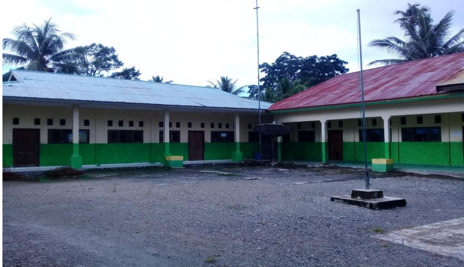
Gambar 1.1 Gedung Madrasah Tsanawiyah Alkhairaat Sidole
