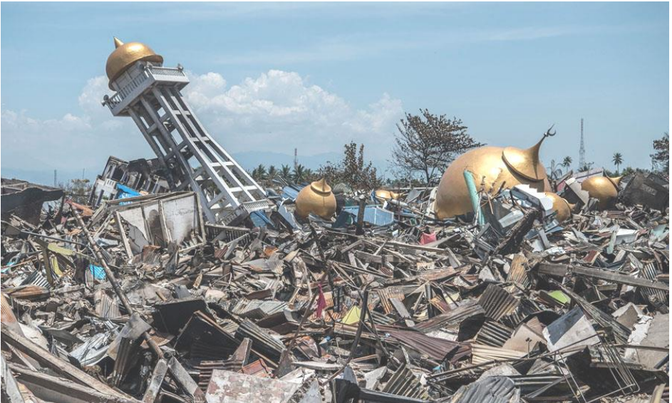
(Perumnas Balaroa, Hancur porak poranda, bercampur aduk antara bangunan satu dengan bangunan lainnya)
