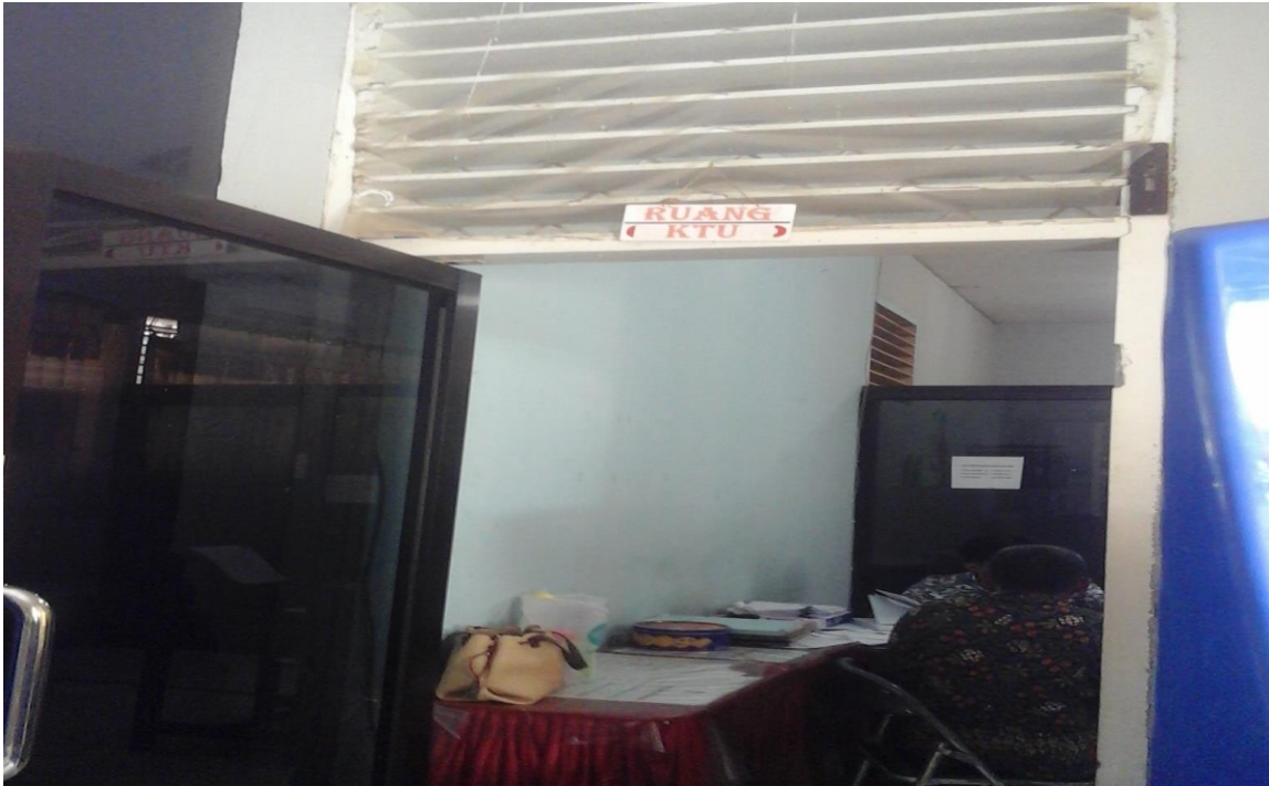
Gambar III. Gedung Tata Usaha
