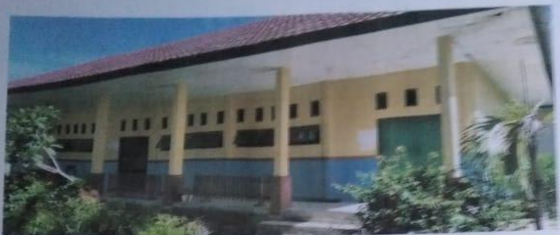
Gedung Kelas TKJ (Teknik Komputer dan Jaringan)
