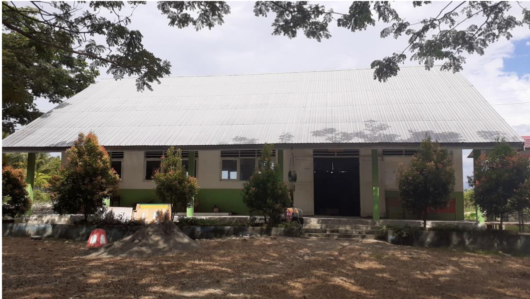
Gambar 3. Gedung Perpustakaan, Ruang Guru Serta Ruang Kepala Sekolah SMP Negeri 1 Sarjo
