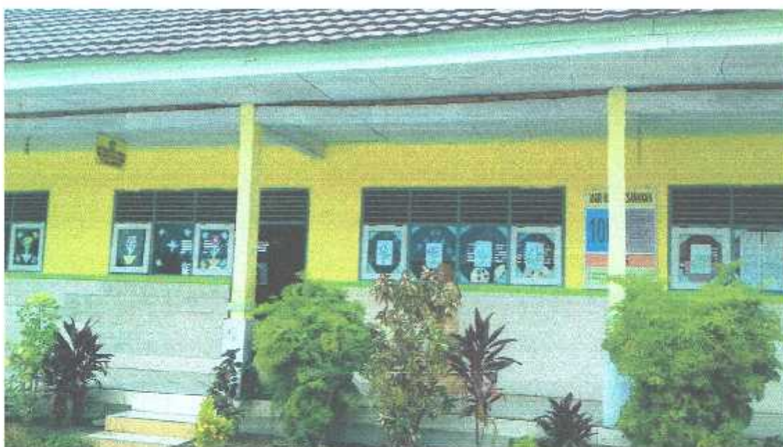
Gambar 2. Gedung Bagian Depan SDN 9 Palu Barat
